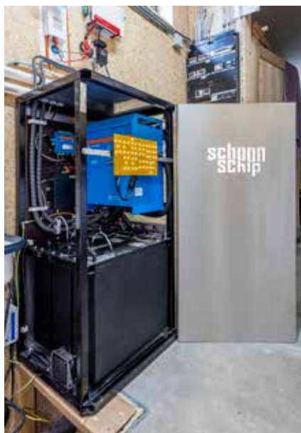
In opdracht van SpectralUtilities levert marktleider in energieopslag Top Systems B.V. de lithium accusystemen voor de waterwoningen, inclusief de beveiligingen, energie-omvormers en besturingssystemen.
