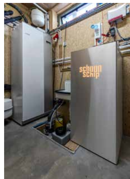
In opdracht van SpectralUtilities levert marktleider in energieopslag Top Systems B.V. de lithium accusystemen voor de waterwoningen, inclusief de beveiligingen, energie-omvormers en besturingssystemen.
