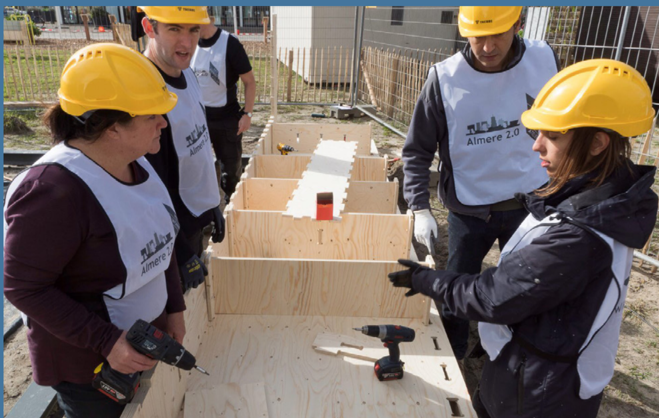
> Het WikiHouse in aanbouw op de BouwEXPO in Almere.
